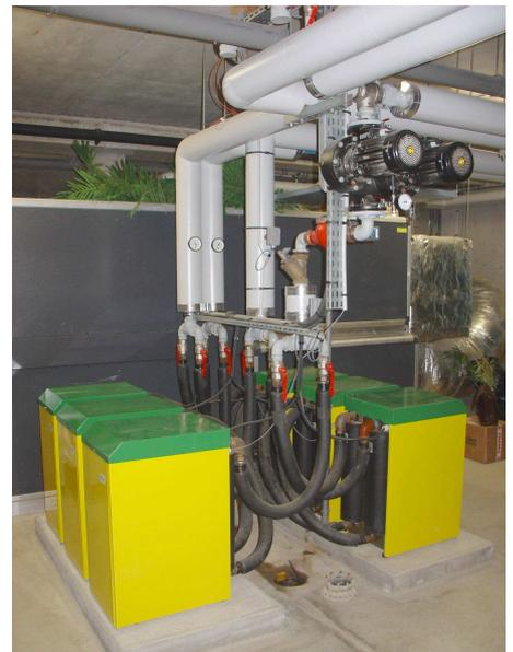
Les 6 PAC, de faible encombrement, permettent une implantation dans un local technique réduit
