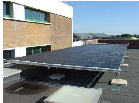
Le capteur solaire en EPDM est posé sur un support en acier galvanisé en toiture terrasse
