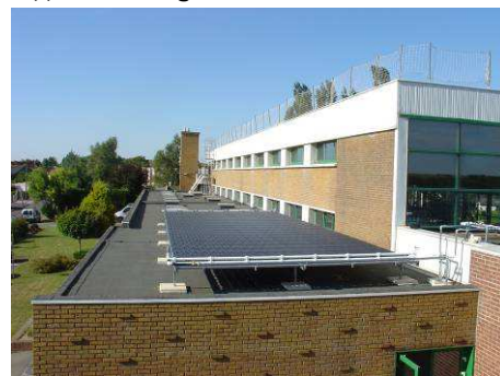
Le capteur solaire en EPDM est posé sur un support en acier galvanisé en toiture terrasse
