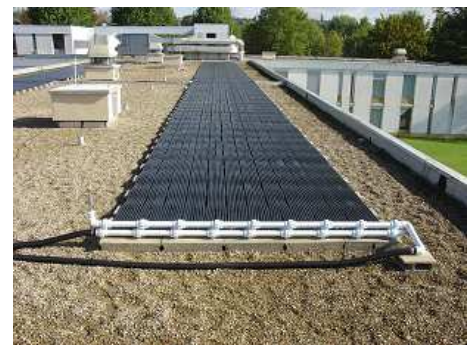
Le capteur fabriqué sur mesure permet de s'adapter aux diverses configurations de toitures
