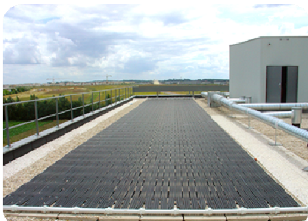
Le capteur solaire est posé ici directement sur des parpaings disposés en toiture. Parfaitement intégrés au bâti, ils sont invisibles depuis le sol.
