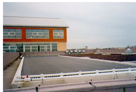
Le capteur solaire en EPDM est posé sur un lit de parpaings.
