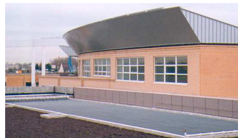
Le capteur solaire en EPDM est posé sur un lit de parpaings.
